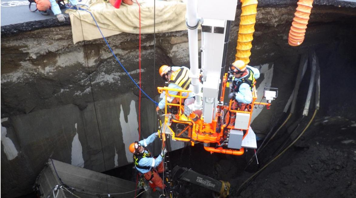
前述のとおり、要救助者を救助するためには、まず、キャビン後方に堆積した土砂等を除去し、キャビン内部に進入する必要がある。これをスコップ等により人力で行うには、相当の危険を伴い、かつ、長時間に及ぶと考え、油圧ショベルによる掘削を行う案があがった。しかし、陥没穴の縁は二次崩落の危険性が否定できない状況であり、5 mとしていた進入制限区域内に油圧ショベルを近づけることはできず、油圧ショベルのアームの長さを考慮すると、進入制限区域の外から深さ約9 mの場所の掘削をすることは不可能であると考え、要請を断念した。
