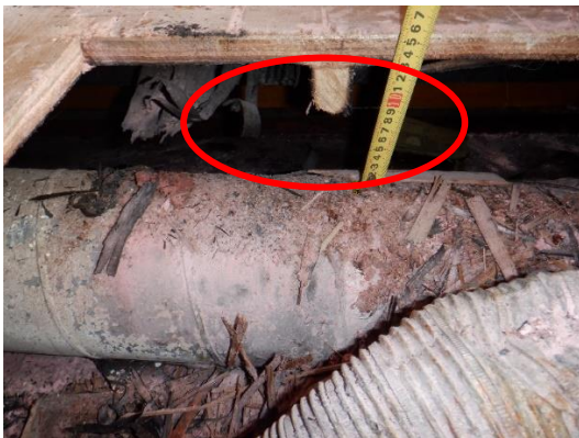
排気ダクトと可燃物との間に適切な離隔距離が取れていない
