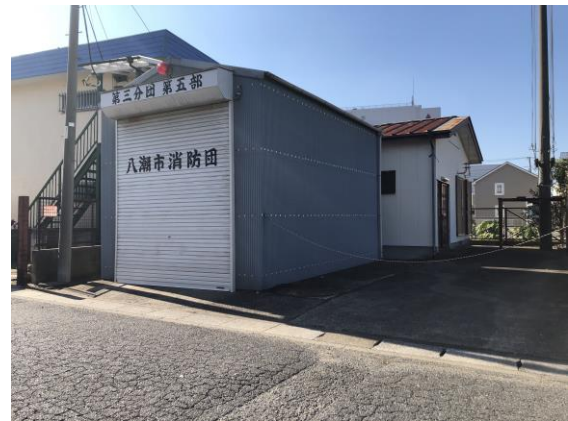
詰所と車庫が別棟（車庫裏側が詰所）
