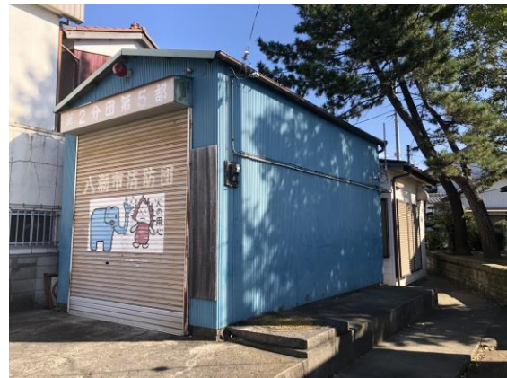
詰所と車庫が別棟（車庫裏側が詰所）
