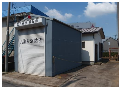
図表 144 八潮市消防団第3分団第5部 詰所と車庫が別棟（車庫裏側が詰所）
