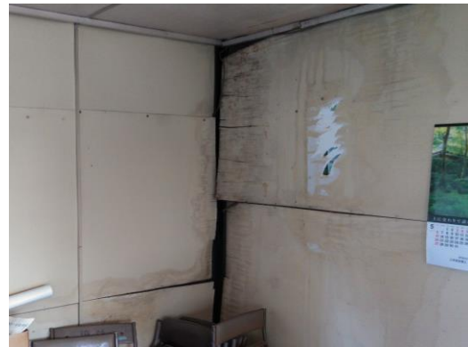
図表 142 草加市消防団第 3 分団第 3 部 雨漏りによる劣化状況
