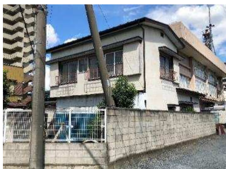
図表 2-2 草加消防署 隣接旧官舎
