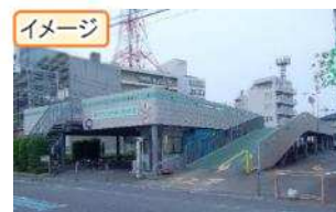
図表 3-58 屋外駐車場 (立体2階建て)
