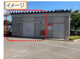
図表 3-51 屋外倉庫（左側）
