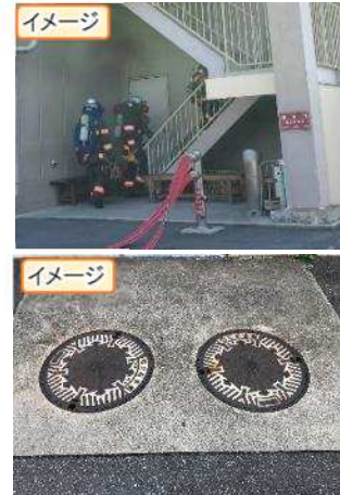
図表 3-26 八潮消防署 上：連結送水管へホース接続 下：防火水槽
