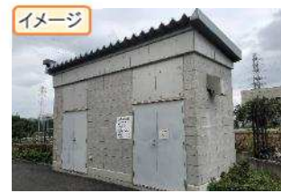
図表 3-62 廃棄物倉庫
