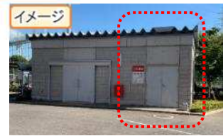
図表 3-21 危険物倉庫（右側）
