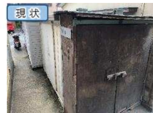
図表 3-52 屋外倉庫
