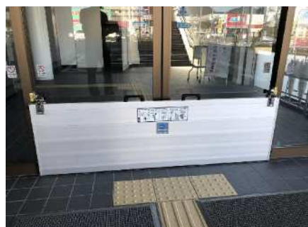
図表 5-9 止水板（浸水対策の一例）
