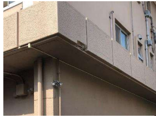
図表 2-7 消防署外壁の一部が欠損
