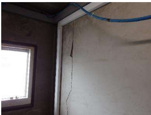
図表 2-8 消防署内壁に発生したクラック
