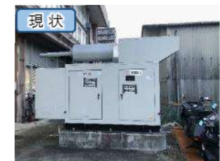
図表 3-57 地上面に設置している非常用電源設備
