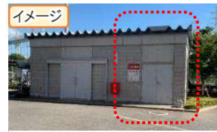
図表 3-21 危険物倉庫(右側)
