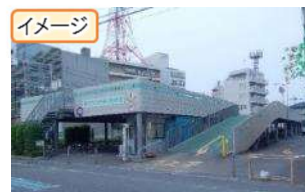
図表 3-58 屋外駐車場 (立体2階建て)
