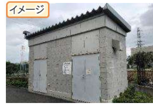
図表 3-62 廃棄物倉庫
