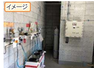
図表 3-22 ポンベ充填庫内
