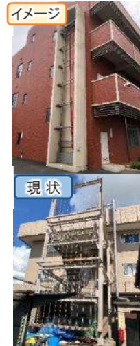
図表 3-27 乾燥設備
