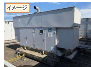
図表 3-56 非常用電源設備
