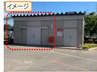
図表 3-51 屋外倉庫（左側）
