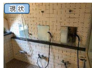
図表 3-47 仕切り板が設置できない浴室
