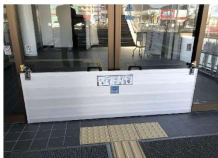
図表 5-9 止水板（浸水対策の一例）
