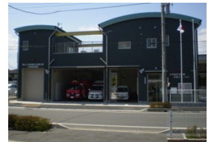
草加消防署谷塚ステーション
