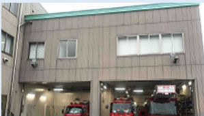
《庁舎内車庫》 配置される車両が入る車庫
