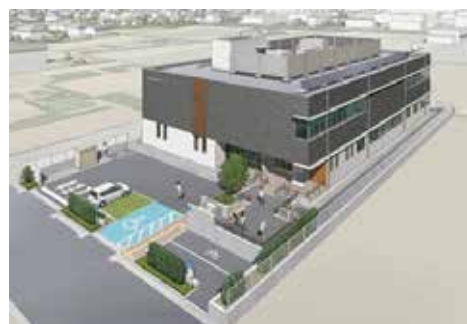
共同消防指令センター所在地 越谷市大字大泊309番地1
